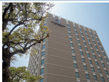
外観 那覇空港からモノレールで約10分、那覇バスターミナルから徒歩約2分、「旭橋駅」目の前の好立地です。
